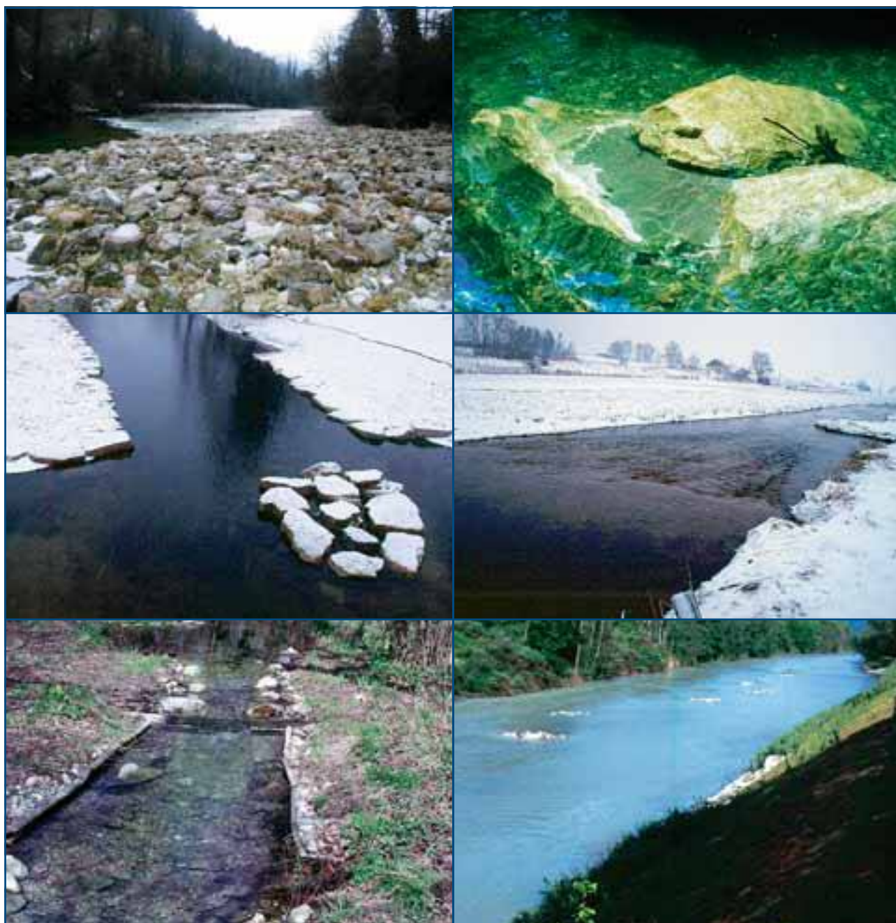
Figure 8 : Différents exemples d'aménagements essentiellement piscicoles : en haut à gauche risberme en enrochements sur la Bienne (39), en haut à droite agencement de blocs sur la Savoureuse (90), au centre amas de blocs et radier artificiel sur le Drugeon (25), en bas à gauche caches artificielles sur un petit ruisseau affluent de l'Allondon (Suisse, canton de Genève) et en bas à droite aménagements piscicoles sur l'Arve (74). ≡
