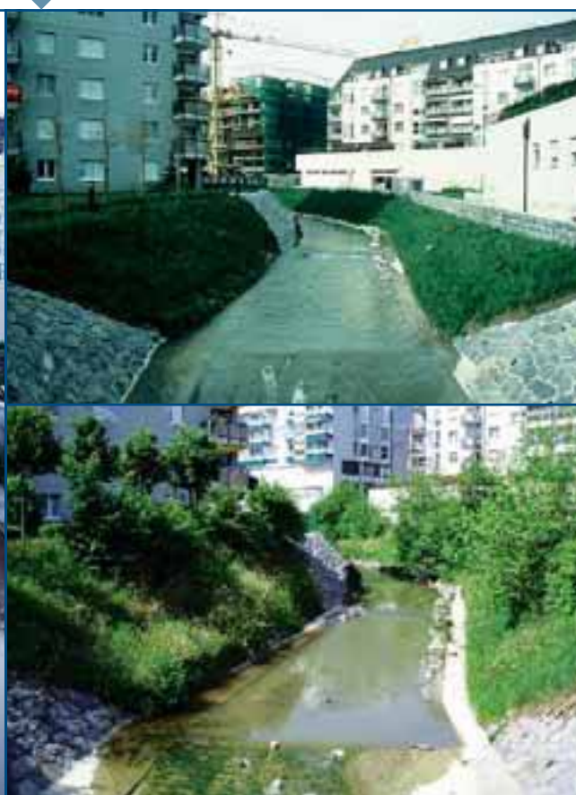
Figure 12 : Exemple d'élargissement hydraulique d'un cours d'eau (la Morges en traversée de ville en Suisse) et réaménagement du lit sous forme de petits seuils, végétalisation partielle des berges, etc. Restauration assimilable à un niveau R1. A gauche état initial, à droite deux puis sept ans après les travaux. ≈
