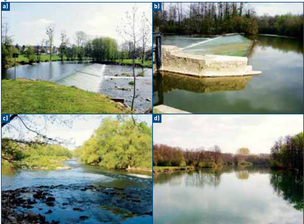
Figure 35 : a) et b) Exemples de seuils. c) Portion naturelle relictuelle présentant des faciès d'écoulement et des milieux diversifiés (bancs alluviaux diversément végétalisés). d) Vue « classique » de la retenue générée par l'ouvrage : un faciès lentique homogène sur plusieurs centaines de mètres. ≡
