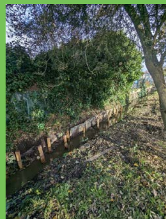
Berges avant travaux
