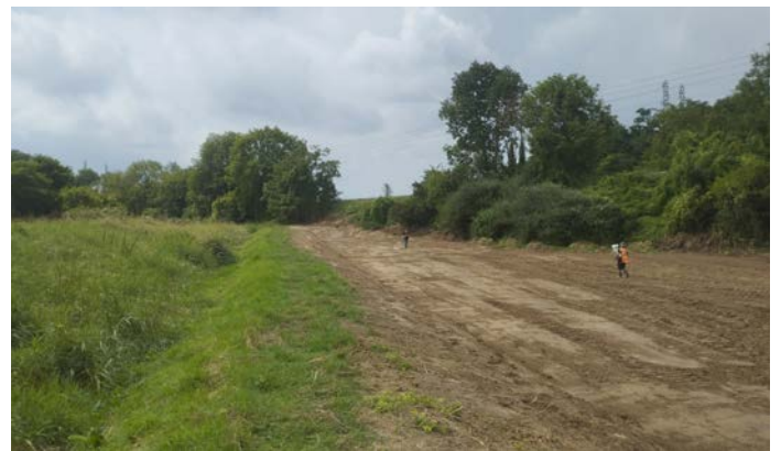
Bassin après travaux
