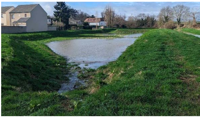
Bassins de stockage à Villeny
