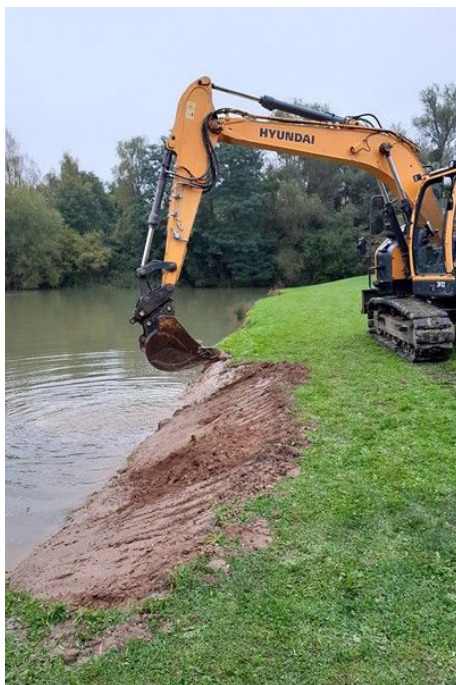
Pendant les travaux_Phase de retalutage
