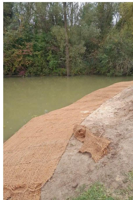
Pendant les travaux_Pose du géotextile
