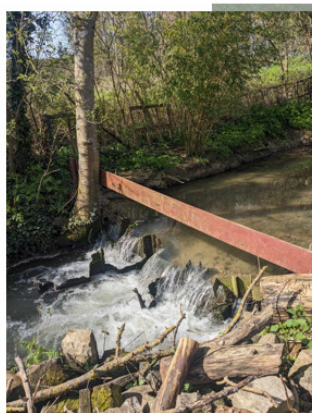
Obstacle 1 : Seuil en palplanches chez M. Levêque
